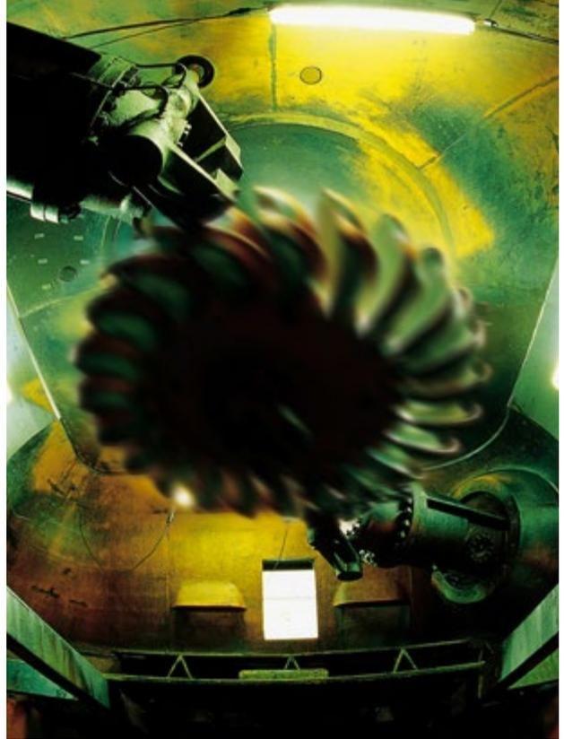
Faszination Technik: Pelton-Turbine im Wasserkraftwerk.
